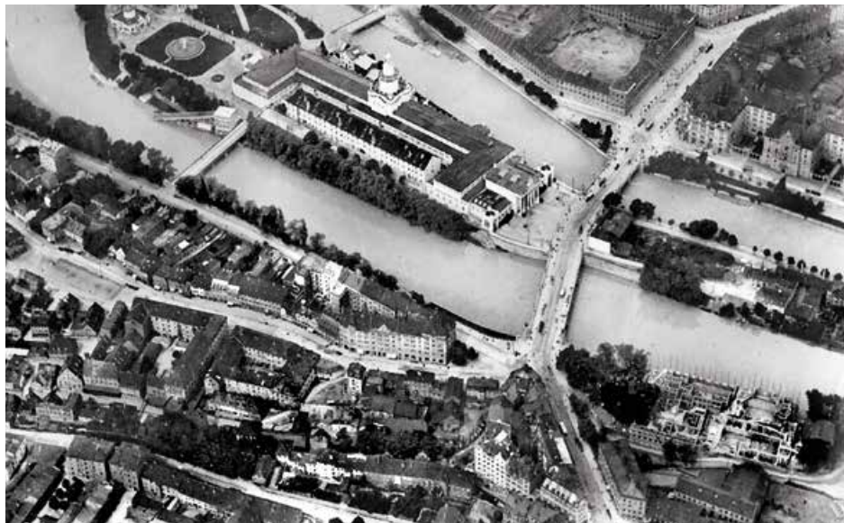
Luftbild aus einem Ballon im Jahr 1898: Blick auf die Museums- bzw. Kohleninsel und auf einen Teil der Au; rechts unten im Foto die Großbaustelle zum Müllerschen Volksbad.
