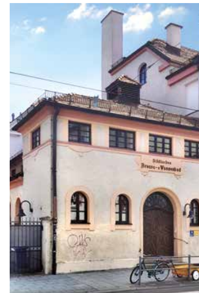
Im Brause- und Wannenbad in der Haidhauser Schloßstraße, das 894/95 gebaut wurde, residiert heute ein Kindergarten.
